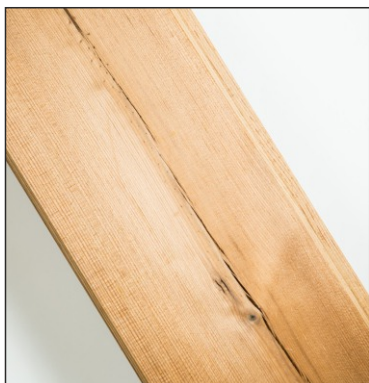
Malé praskliny na povrchu prken jsou povoleny
